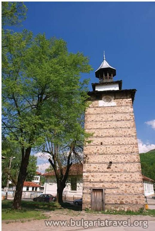
Часовая башня в городе Этрополе была построена в 1710 г. мастером-строителем Тодором и считается одной из старейших в Болгарии. Сооружение высотой 20 м. сделано из речного камня и известнякового туфа.
