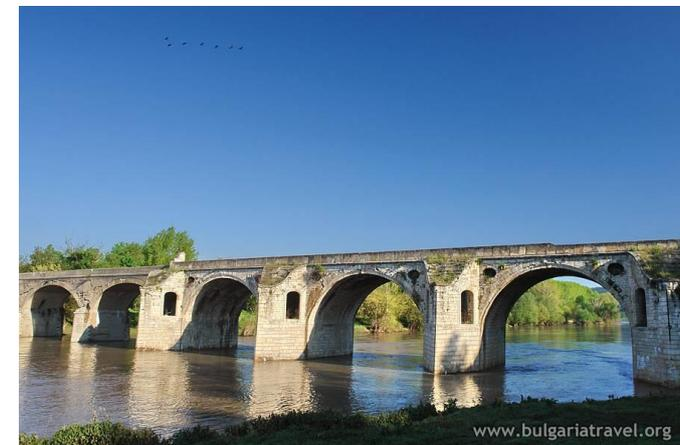
При строительстве моста Колю Фичето помогли кузнецы из Габрово, плотники и каменщики из Трявны и Дряново и крестьяне из г. Бяла. Длина моста 276 м., ширина 9,5 м., он имеет 13 быков и 14 полукруглых сводов. Посередине возвышается колонна, на которой установлена мраморная плита с надписью арабскими буквами.
